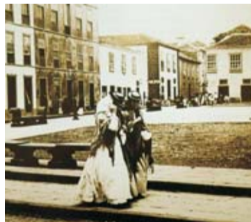
Canapés, losas chasneras y petriles basálticos. A ambos lados de la plaza, se advierte el espacio reservado a los dos estanques. Inicios del siglo XX.
